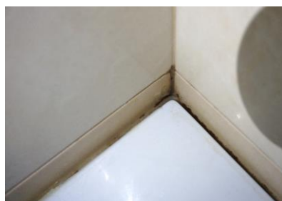
detail spár – vpravo ve spáře stopy plísní
