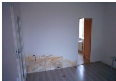
obývací pokoj – stopy vlhkosti
